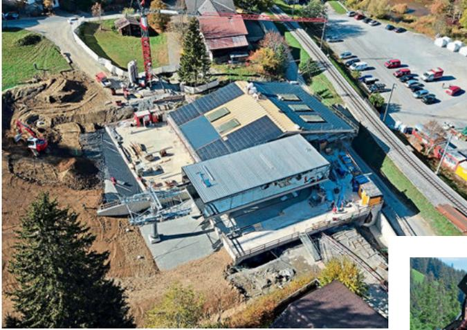
Talstation Saanerslochbahn mit unterirdischer Garagierung im Bau. Sie fügt sich nach den Plänen vom Architekturbüro Jaggi & Partner gut ins Ortsbild ein. Auf dem Dach wurden Photovoltaik-Module platziert.
